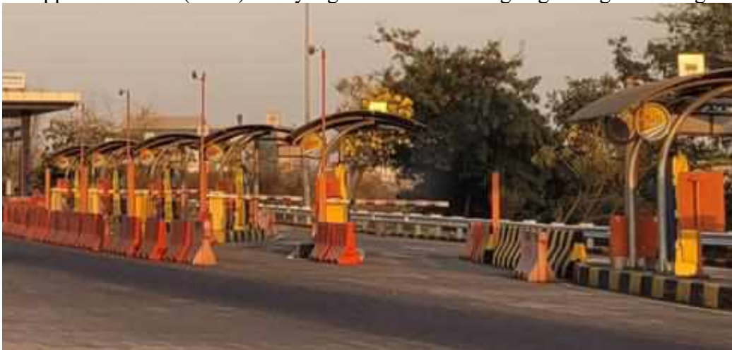
Gambar 1. Oblique Approach Booth (OAB) Pada Gerbang Tol Warugunung
